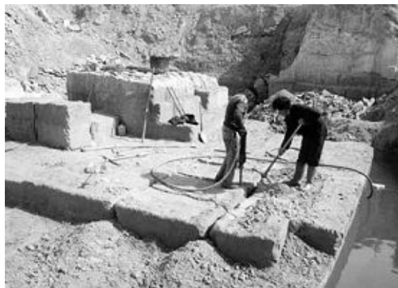
Figura 3. Trabajos de extracción del mármol, en Macael a principios del siglo XX.
