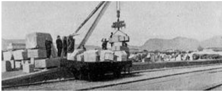
Figura 4. Transporte en grúa de los bloques de mármol para su transformación. Fotografía cedida por gentileza del Instituto de Estudios Almerienses.
