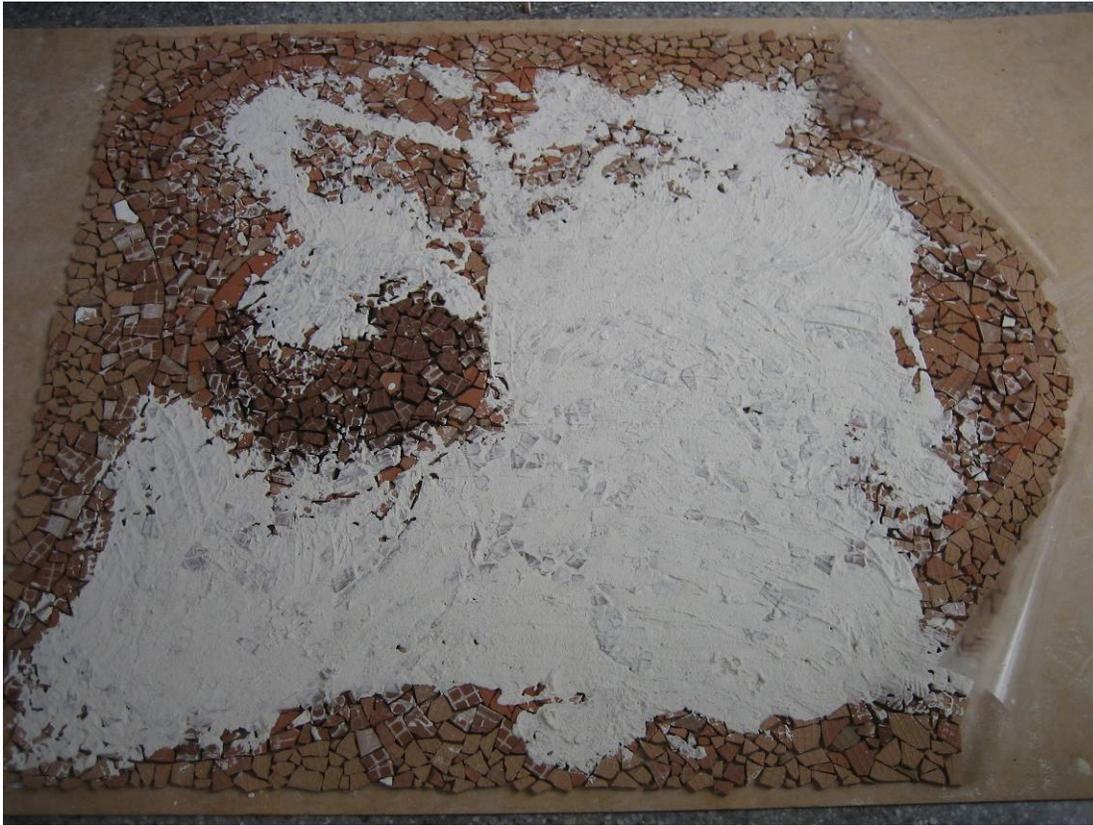
Mientras, uno o dos miembros del grupo, pueden ir preparando un cubo con mezcla de cemento suficiente para cubrir todo el soporte del mosaico. Se aplica una capa gruesa de este cemento sobre el soporte sobre el que colocaremos el mosaico.
