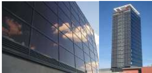
Fig. 3. Instalación solar fotovoltaica sobre fachada edificio
