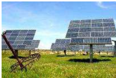
Fig. 9. Seguidores solares a dos ejes
